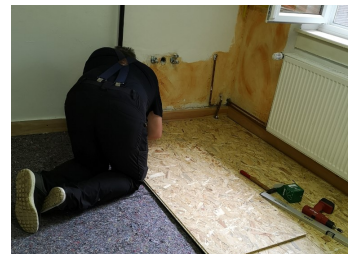
Unterbau für den pflegeleichten Boden
